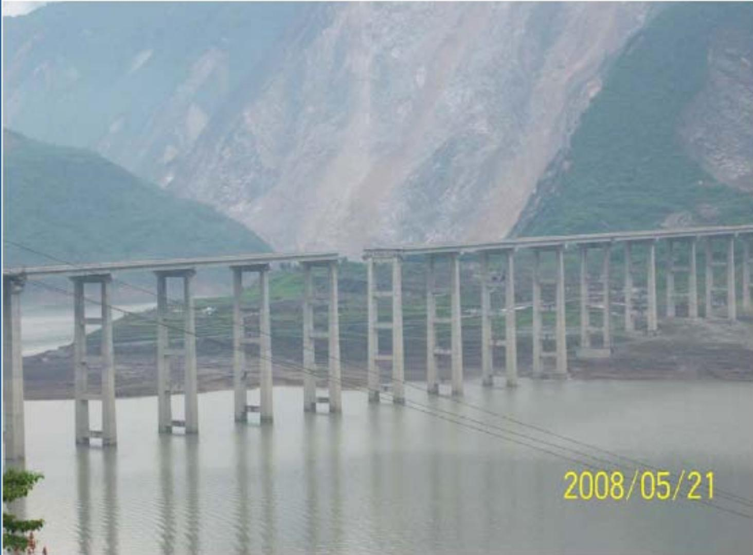
图 1 庙子坪大桥引桥落梁
